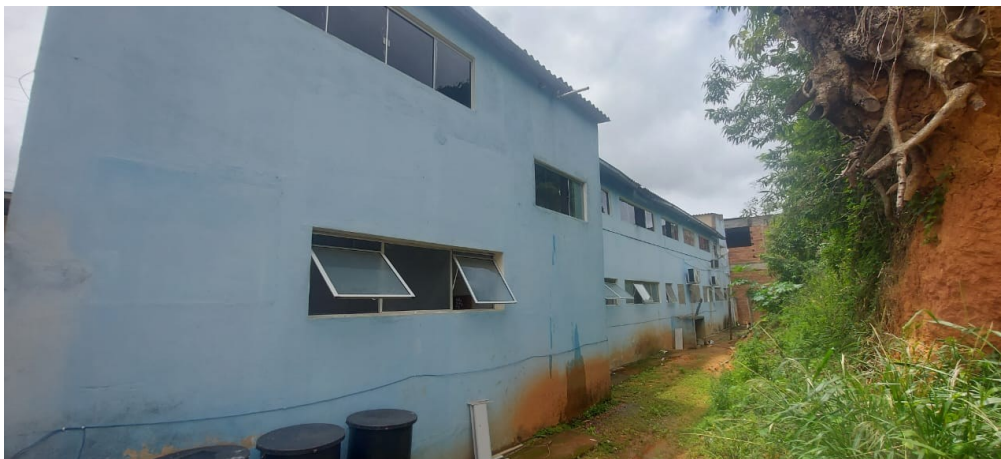
Descrição: Área externa da UBS.
