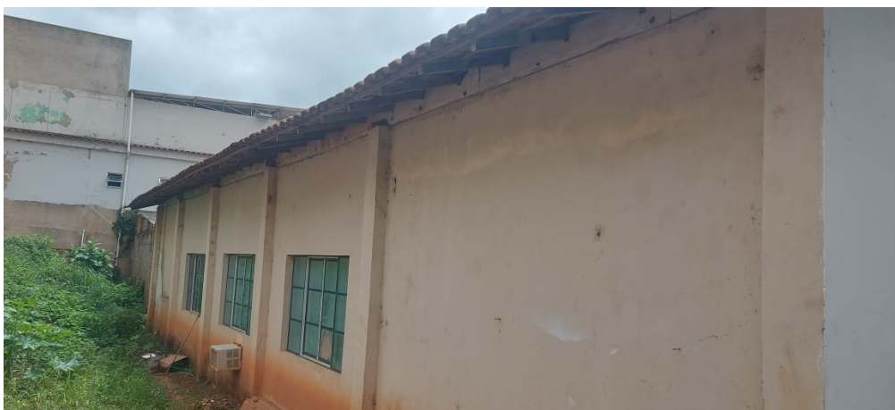
Descrição: Área externa da UBS.
