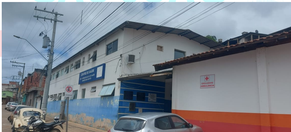
Descrição: Acesso a UBS.
