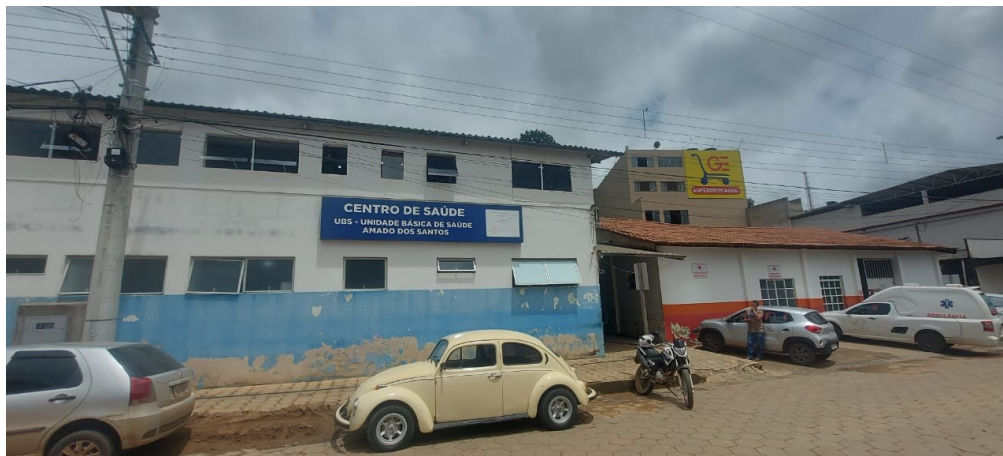
Descrição: Fachada da UBS.
