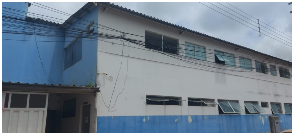
Descrição: Fachada da UBS.
